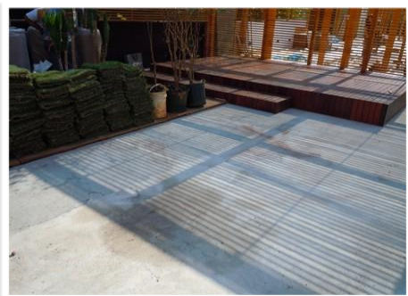
1. Laje impermeabilizada pré-existente
