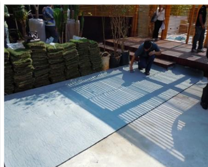
3. Aplicação da manta geodrenante e/ou bidim
